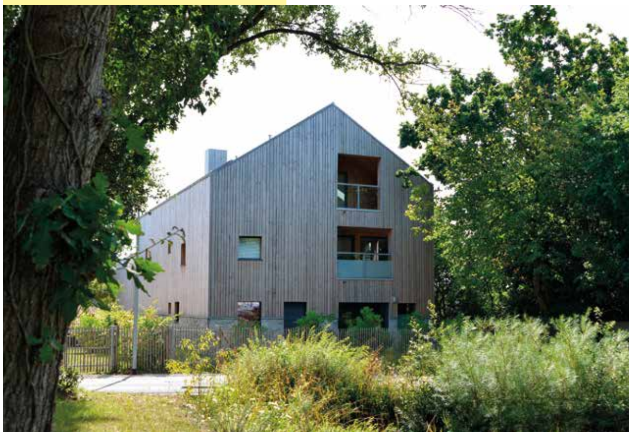
L'écoquartier du Courtil-Brécard à Saint-Nazaire.
