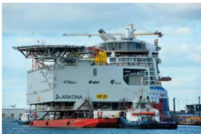
La sous-station électrique Arkona fabriquée par les chantiers STX.
