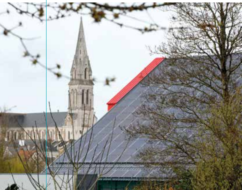
Installation de panneaux solaires à Saint-Joachim.
